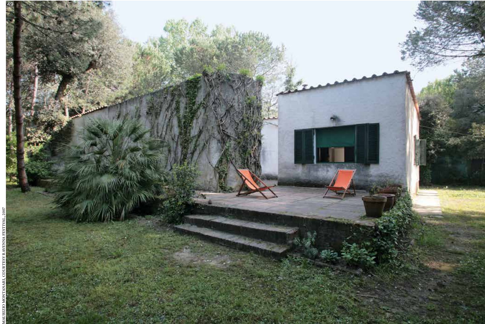
49 50 —Casa Savinio, Poveromo, viste da sud-ovest e da nord-ovest —Casa Savinio, Poveromo, views from southwest and northwest 51 52 —Casa Savinio, Poveromo, due scorci del patio e del verde che circonda la costruzione —Casa Savinio, Poveromo, two views of the patio and the vegetation around the construction 53 —Casa Savinio, Poveromo, vista dal tetto del patio da nord-ovest —Casa Savinio, Poveromo, view from the roof of the patio from northwest
